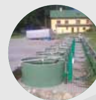
KRUHOVÉ ODCHOVNÉ NÁDRŽE
